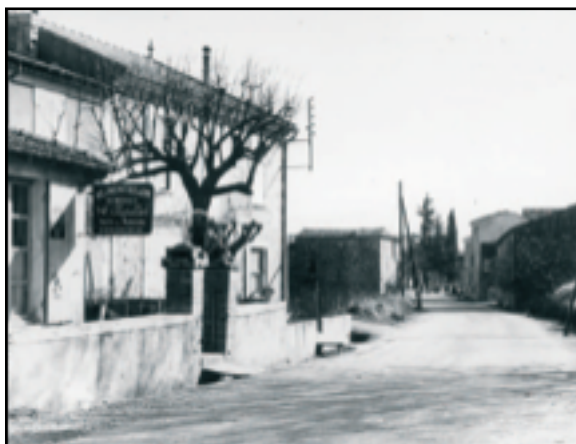
Alimentation générale A. Chapellier
